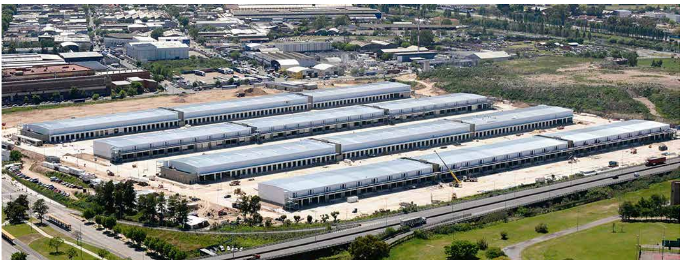
Vista general de la obra terminada. (*)
