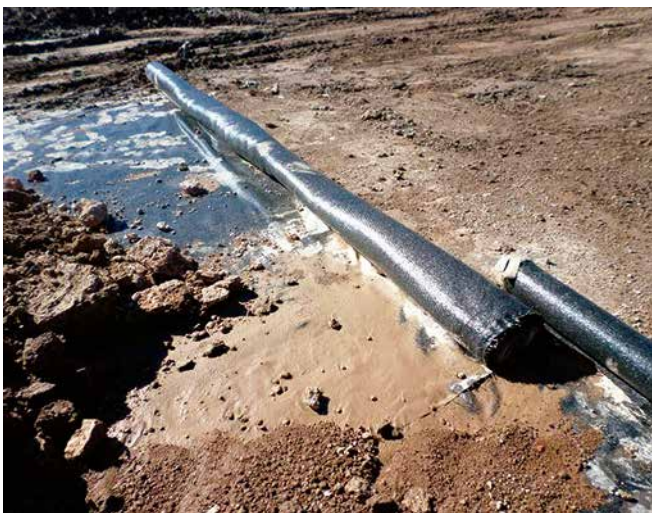
Despliegue del geotextil tejido PlusTex® T J-220 sobre la subrasante.
