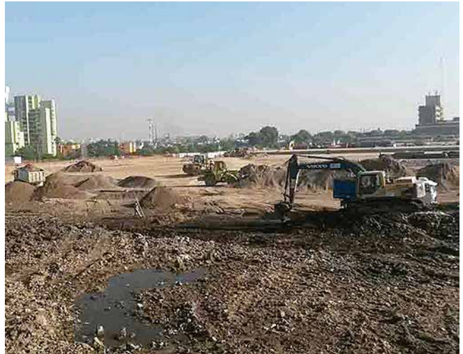
Excavación del estrato superior. (*)
