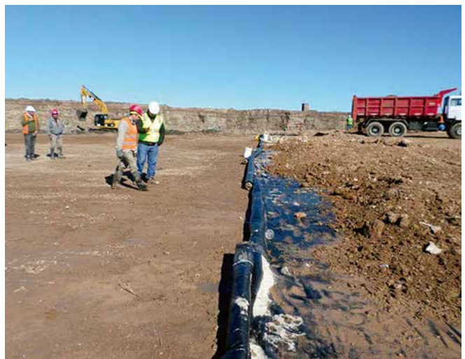
Relleno con suelo seleccionado.
