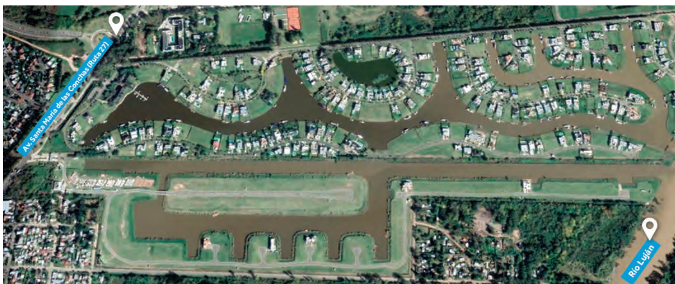
Vista satelital del barrio terminado.
