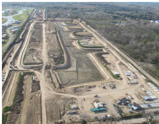
Ejecución del tablestacado en seco.
