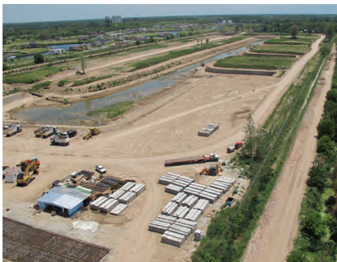
Vista aérea de la excavación y comienzo del perfilado de los lotes.
