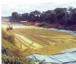
TERRAPLENES SOBRE SUELOS BLANDOS
