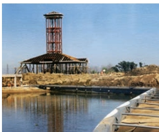
FILTRO DETRÁS DE MUROS CONTENCIÓN
