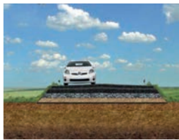
Estabilización de rutas y pavimentos permanentes
