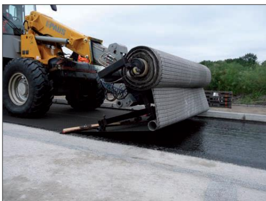
Fig. 5. Instalación con máquinas.
