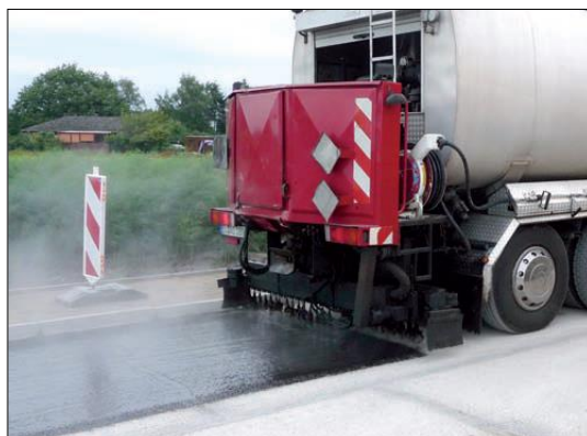
Fig. 2. Riego con emulsión bituminosa.
