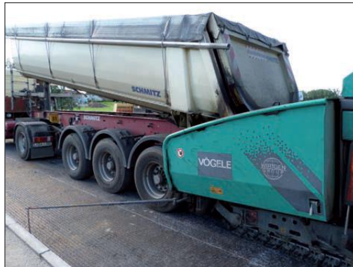
Fig. 9. Ejecución de asfalto.
