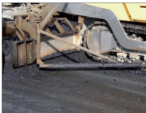
Fig. 7. Detalle de ejecución capa de rodamiento.
