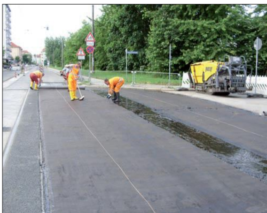
Fig. 4. Colocación parcial del refuerzo.
