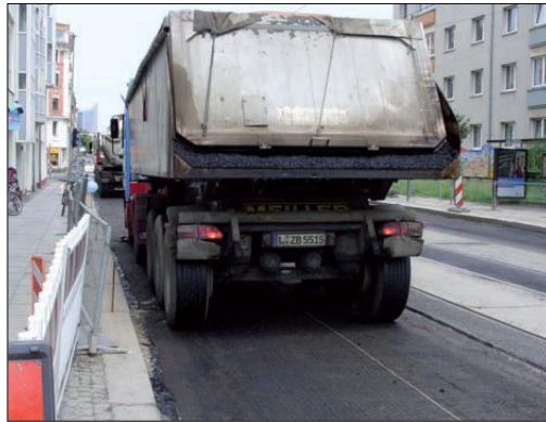
Fig. 8. Ejecución de asfalto.
