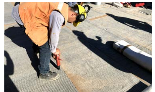
Fijación con clavos de impacto.
