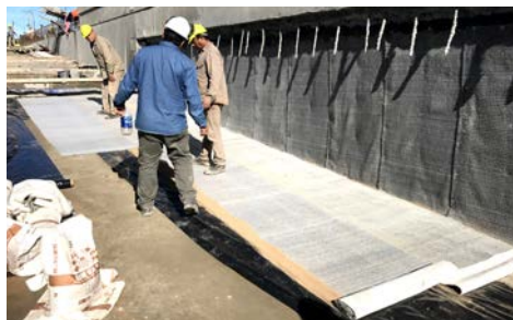
Despliegue de Voltex®. Rápido Avance.
