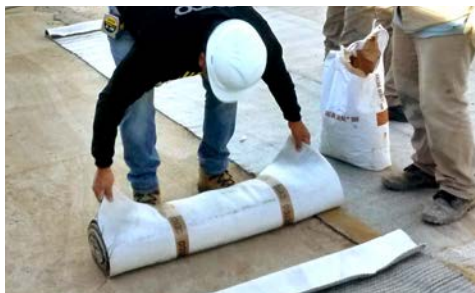
Instalación manual, unión por solape.
