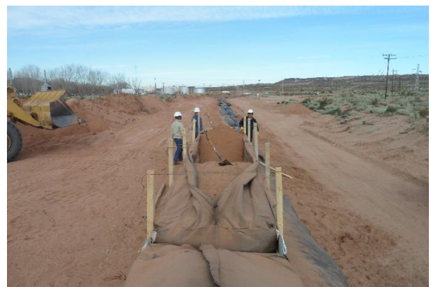
Fig. 2. Acomodo y compactación manual
