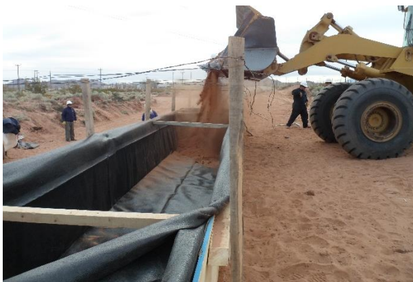
Fig. 1. Llenado con pala cargadora
