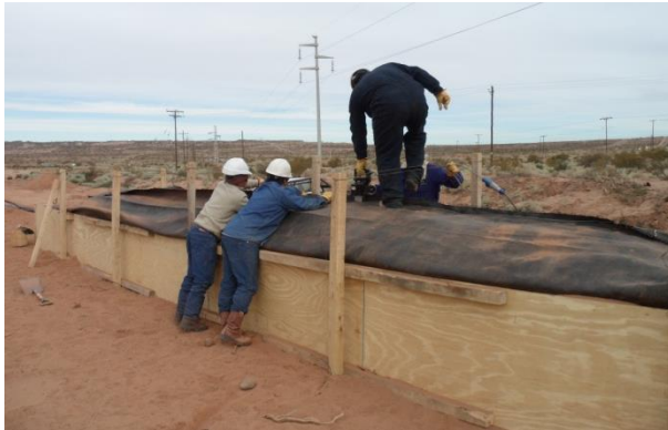
Fig. 3. Costura con máquina portátil
