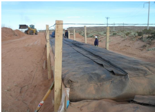
Fig. 5. Geotubos®RS Box encofrados
