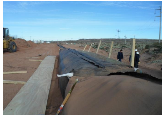
Fig. 6. Retiro de encofrados
