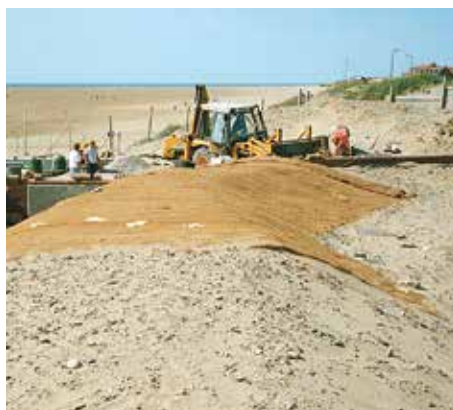
Estabilización de suelos arenosos
