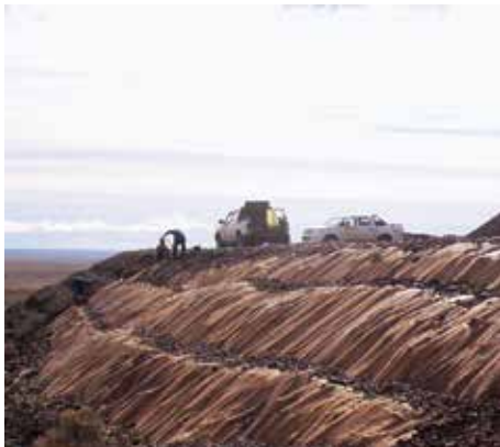
Protección de taludes
