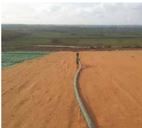
Cierre de rellenos sanitarios
