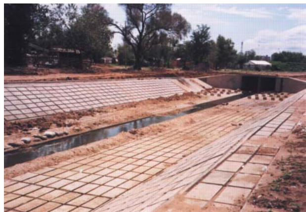
Foto 6: Vista del tramo terminado.
