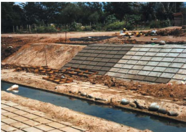
Foto 5: Vista de un paño parcial terminado y recién desencofrado.
