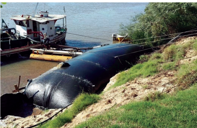
GeoTubo® RH - Defensa Isla Almirón, Entre Ríos
