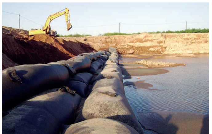
GeoTubo® RH - Estabilización de cárcava, Stgo del Estero
