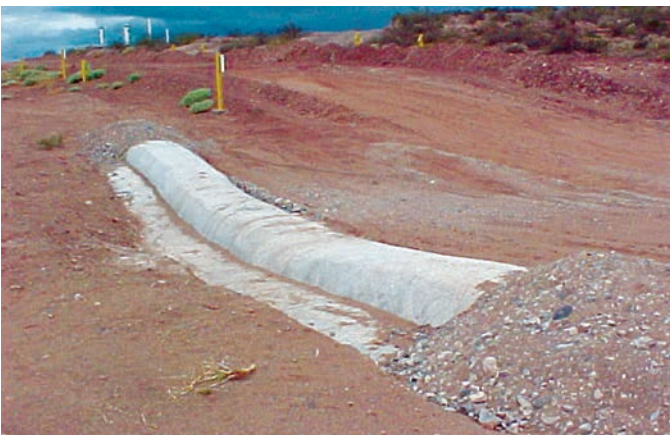
GeoTubo® RS - Azud protección de ductos YPF - Neuquén
