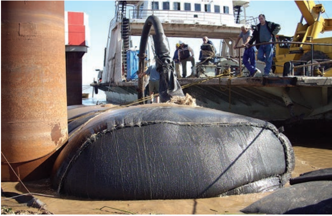
GeoTubo® RH - Protección Torre Yacylec - Paso de la Patria, Corrientes
