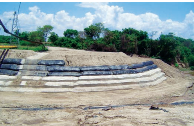
GeoTubo® RS - Protección de gasoducto - TGN, Salta
