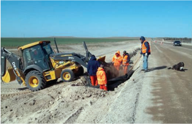
GeoTubo® RS - Defensa contra inundaciones - Ruta 3 Km 920 - Buenos Aires
