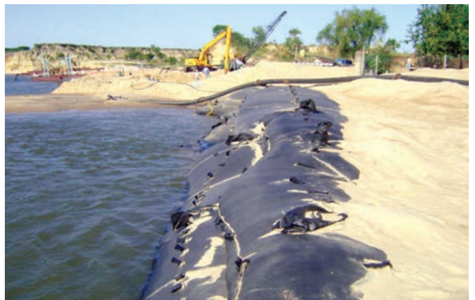
GeoTubo® RH - Recuperación playa - Empedrado, Corrientes
