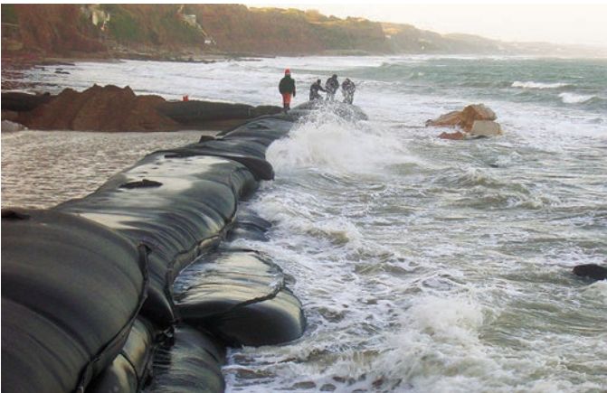
GeoTubo® RH - Espigones y defensa Los Acañilados - Mar del Plata, Bs. As.
