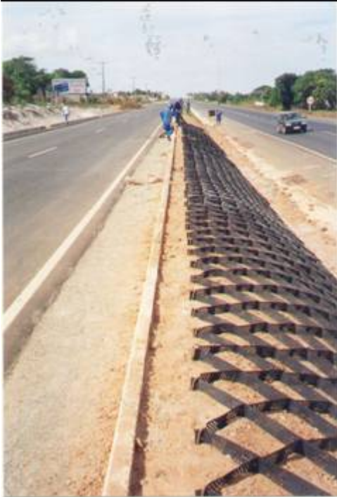
Detalhe da instalação do Geoweb.
