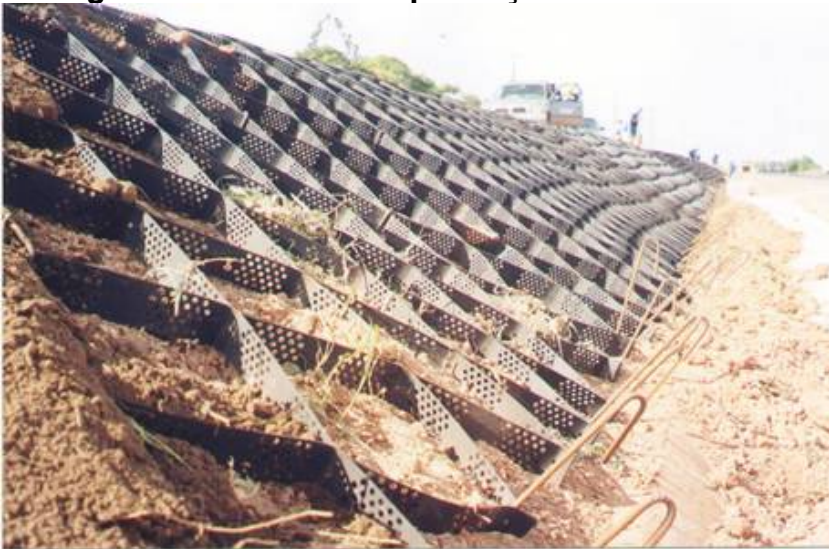
Geoweb instalado e pronto para ser revestido. Notar os ganchos de fixação na base do talude.
