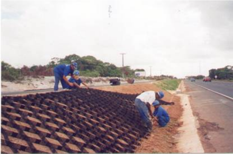
Detalhe da instalação do Geoweb.
