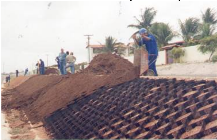
Detalhe do preenchimento das células a partir do topo do talude.
