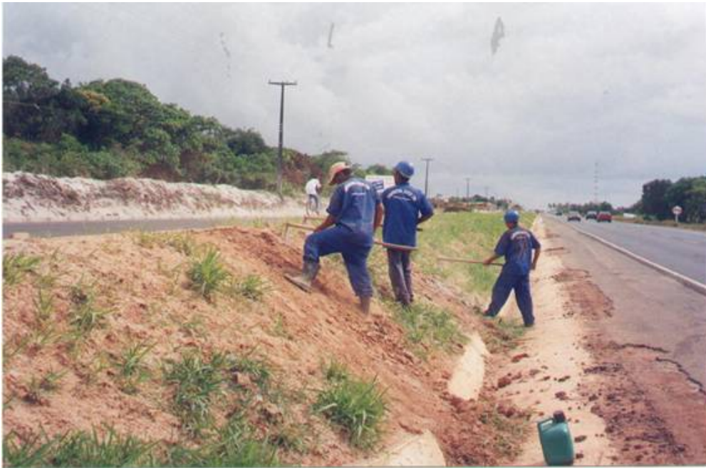
Preparação da superfície para aplicação do Geoweb.
