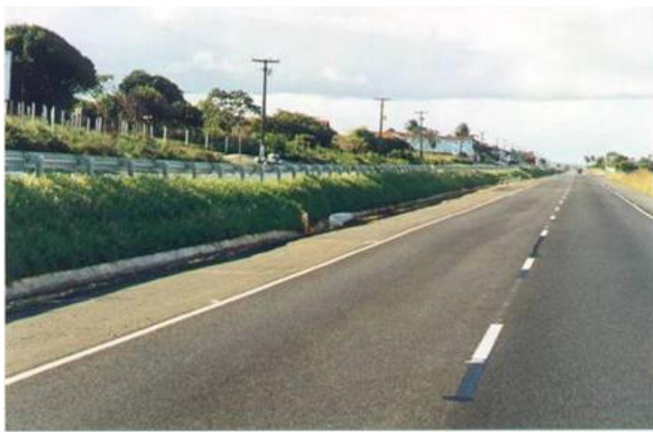
Vistas gerais do trecho após a pega da vegetação. Notar a cobertura vegetal completa do talude, evitando processos erosivos e proporcionando excelente aspecto visual.
