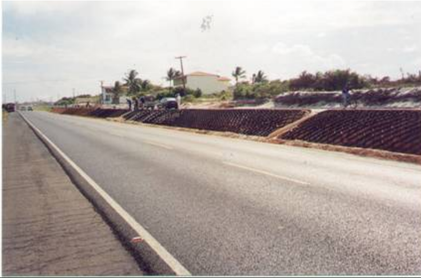
Vista geral do trecho de implantação do Geoweb.
