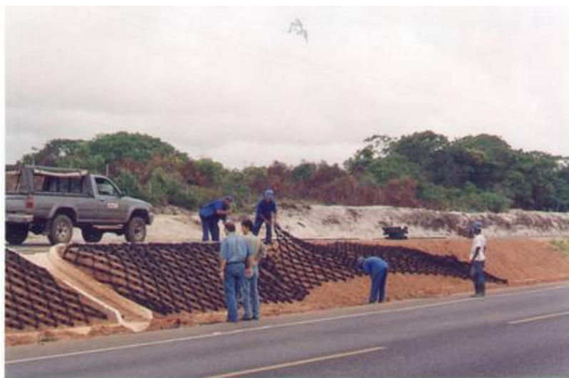
Instalação do Geoweb, sendo aberto paralelamente à rodovia para agilizar e aumentar o rendimento da instalação dos painéis.
