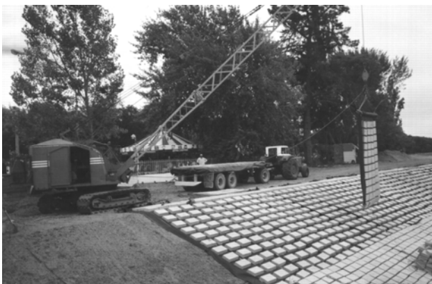
Fig. 3 Colocación de mantas de revestimiento
