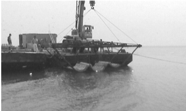
Fig. 9 Instalación de la manta
