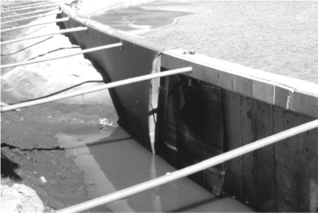
Fig. 5 Ejecución del pleno drenante
