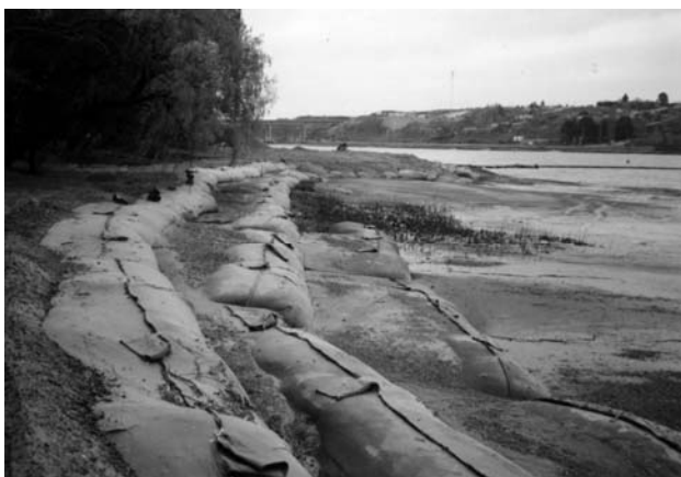
Fig. 1 Geotubos de geotextil no tejido
