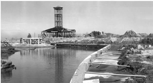
Fig. 6 Vista obra terminada
