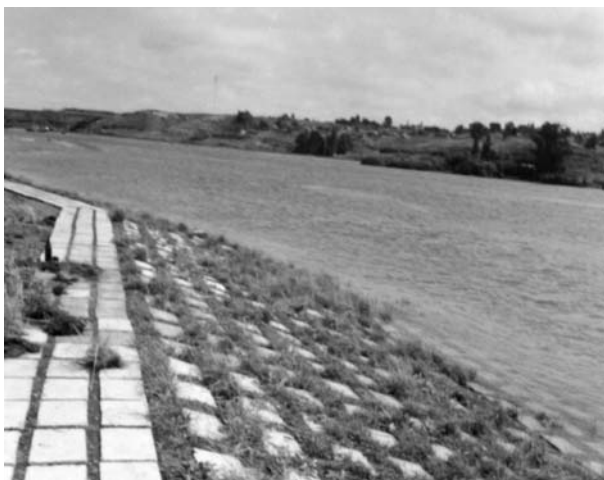
Fig. 4 Vista de la obra terminada
