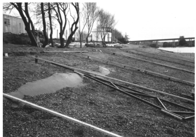
Fig. 2 Manto drenante y perfilado del talud
