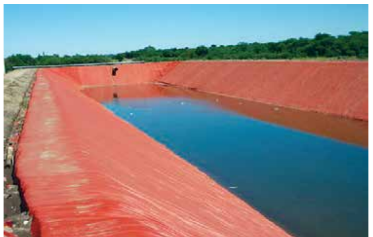
Pileta de agua pura para riego - San Luis
